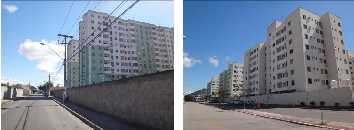
Figura 2 – Empreendimentos Minha Casa Minha Vida no município da Serra –ES. Monofuncionais, grandes extensões de muro, repetição de blocos, monotonia)
