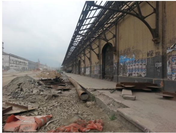
Figura 6: Armazéns da Zona Portuária
