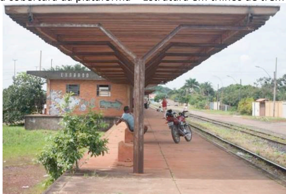
Figura 5: Detalhe da estrutura da cobertura da plataforma – Estrutura em trilhos de trem e cobertura em telha de amianto
