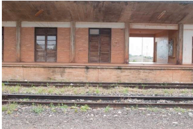
Figura 3: Trecho da Fachada Oeste próximo ao acesso principal (vazio a direita) – Tipologia Construtiva
