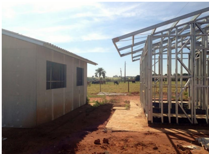
Figura 1: O exemplo do contraste – habitação com desenho tradicional construída em steel frame , em loteamento na extrema periferia (vizinho a uma área de pastagem de gado) da cidade de Uberaba – MG.
