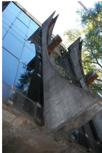
Figura 03: Brise na fachada sul da biblioteca
