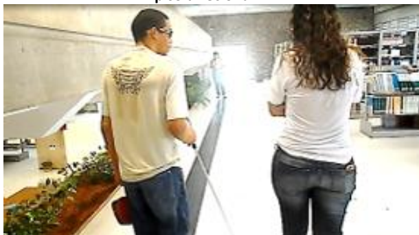
Figura 11: PDV – Piso tátil de alerta utilizado indevidamente como linha guia devido a inexistência do piso direcional
