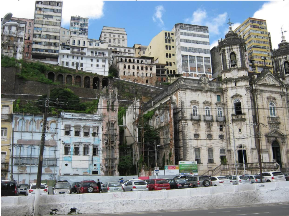
Figura 2: Situação do imóvel localizado à Rua da Conceição, nº 34, no Centro Histórico de Salvador, em março de 2015.
