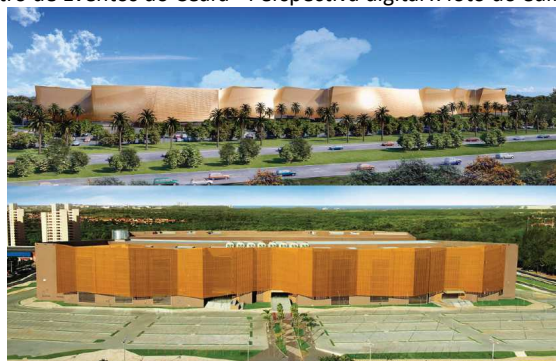
Figura 2: Centro de Eventos do Ceará - Perspectiva digital x foto do edifício construído
