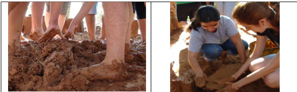
Figuras 17 e 18 - Preparação da matéria-prima para o Adobe e aplicação.
