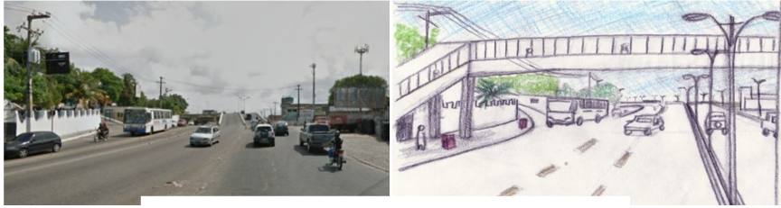
Figura 06: Passarela e calçada na Av. Bernardo Viera.
