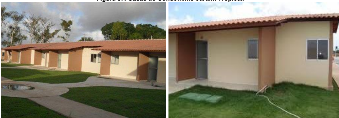
Figura 07: Casas do Condomínio Jardim Tropical.
