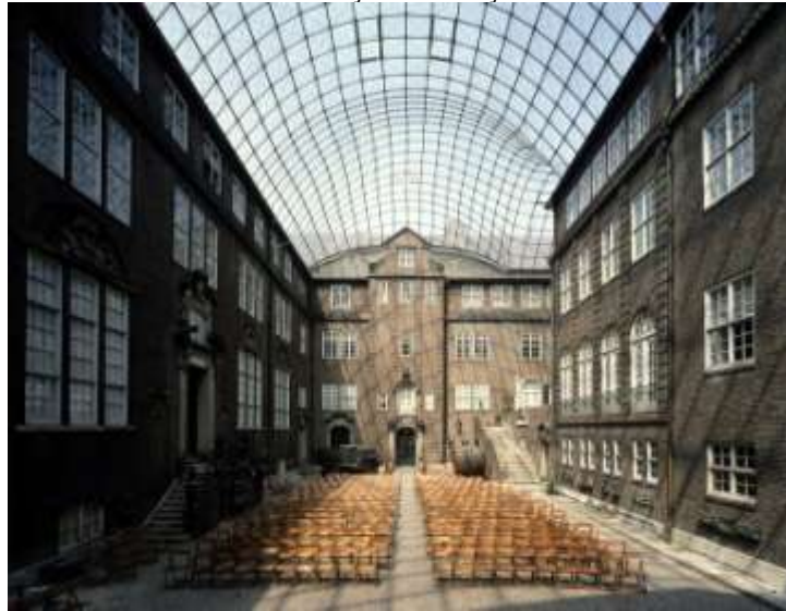
Figura 09 - Historisches Museum Hamburg : compromisso com a preservação e integridade da preexistência e a mínima intervenção na inserção do novo.
