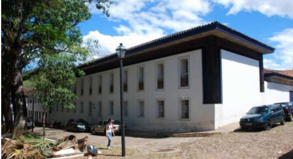
Figura 05- Casa do Bispo, em Mariana. Arquitetos Éolo Maia, Jô Vasconcelos e Sylvio de Podestá. O mito da intervenção criteriosa: limite entre pastiche e “intervenção silenciosa” (sic).
