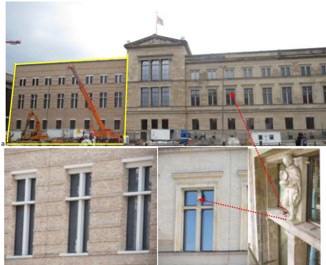
Figura 18 – A reconstituição dos dados espaciais do Neues Museum : a) em amarelo, a ala sudeste; (b) os detalhes da simplificação formal dos novos elementos; (c) em laranja, os elementos originais remanescentes que não foram reproduzidos.
