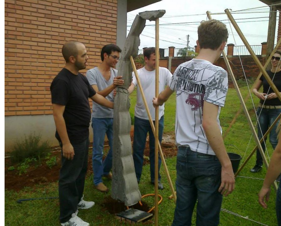
Figura 11: Protótipo da luminária inspirada na tulipa de São sendo escorado e colocado sobre a vala de fundação
