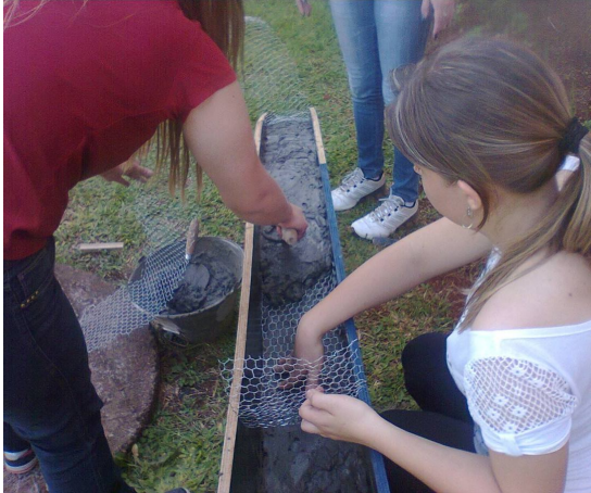
Figura 10: Parte do processo de execução - concretagem do elemento estrutural.
