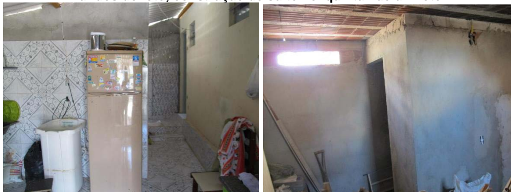
Figuras 20 e 21: Cozinha e área de serviço ocupando todo o terreno disponível nos fundos do lote; construção de suíte no 'quintal' de um lote.
