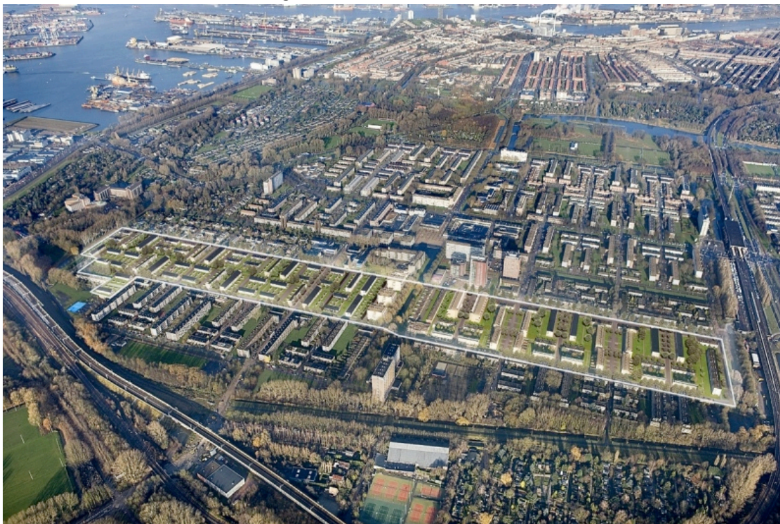
Figura 05: Vista aérea de Pendrecht.
