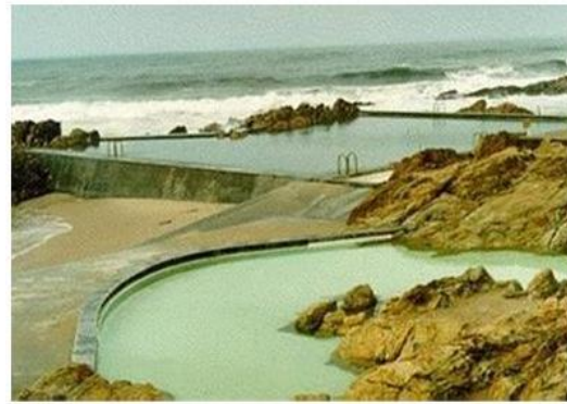
Figura 04: Piscinas das Marés, Leça da Palmeira, 1966. Álvaro Siza.
