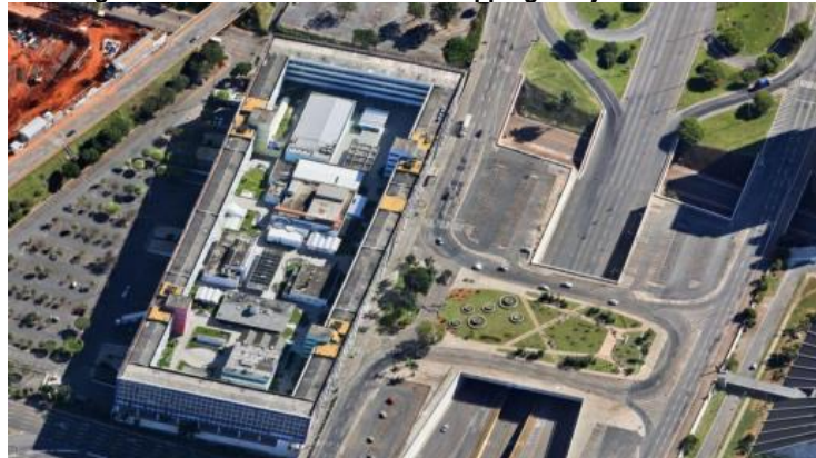
Figura 4: Vista da cobertura do Shopping Conjunto Nacional.
