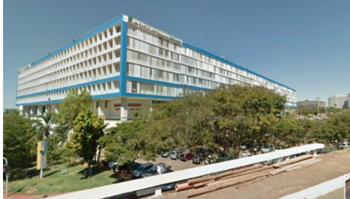
Figura 3: Vista das Fachadas Norte e Oeste do Shopping Conjunto Nacional.
