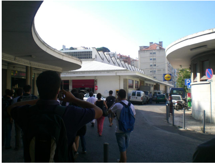
Figura 8 - Mercado do Forno do Tijolo Fonte: foto dos autores (2013)
