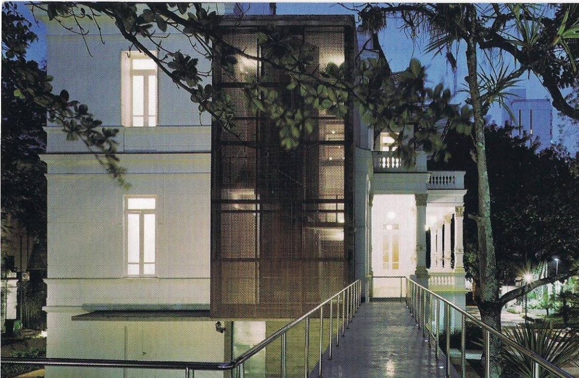
Figura 05: Museu Rodin em Salvador: Vista da fachada posterior do Palacete Martins Catharino, com a chegada da passarela em concreto protendido que o conecta ao novo anexo e a nova torre de circulação vertical.
