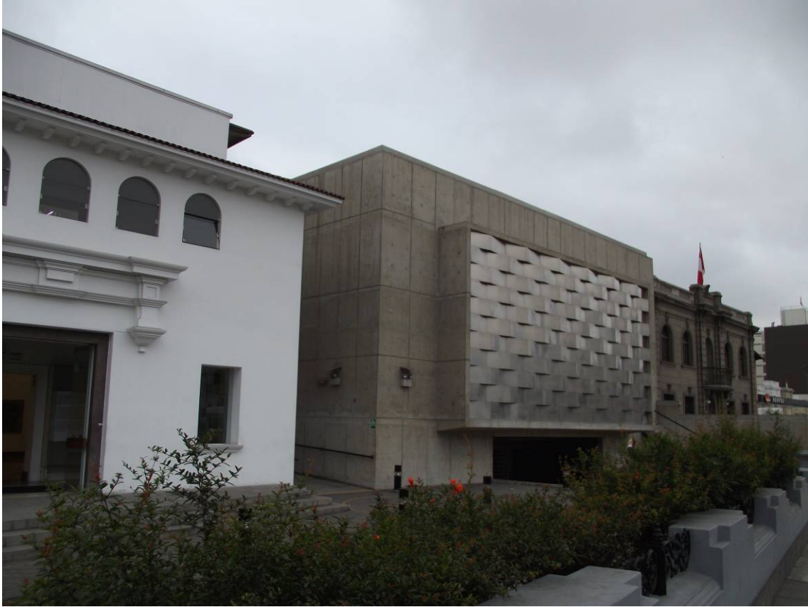
Figura 02: Centro Cultural Ccori Wasi em Lima: Vista geral a partir da Avenida Arequipa, vendo-se à esquerda o edifício preexistente do Centro Cultural, no centro o novo anexo que abriga o auditório e o estacionamento e à direita a edificação vizinha preexistente.
