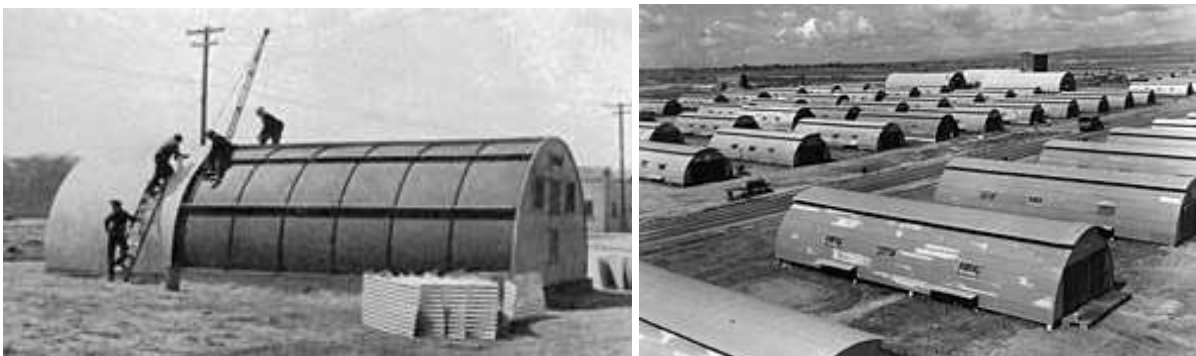
Figura 2. Exemplos do abrigo Nissen Hut . À esquerda a construção de um abrigo; à direita um acampamento militar. Disponível em: < www.quonsethuts.org/book/chapter1.htm >. Acesso em 11 set. 2011.
