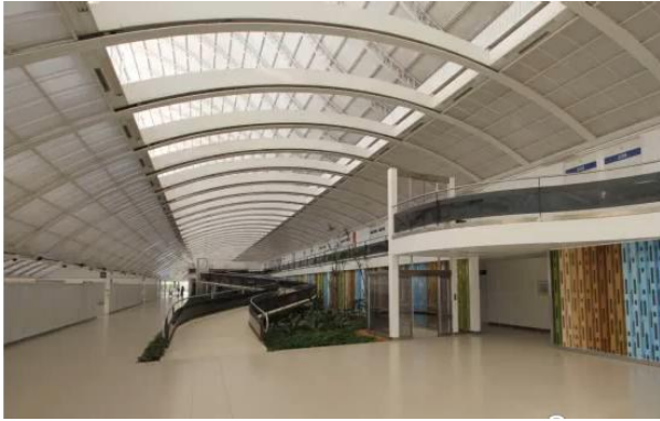
Figura 3. Iluminação zenital na circulação do hospital. Fonte: Museu da Casa Brasileira
