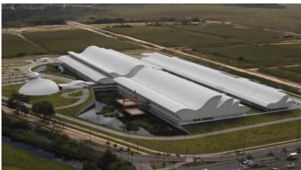
Figura 19. O Hospital é formado por blocos que se interligam. Fonte: www.mcb.sp.gov.br
