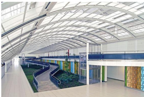
Figura 32. Iluminação zenital através de teto em arco com policarbonato no Hospital Sarah do Rio. Fonte: LEAL, 2008.
