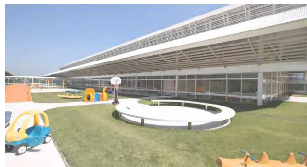
Figura 20. Integração entre meio interno e externo através de esquadrias de vidro protegidas por beirais. Fonte: www.mcb.sp.gov.br
