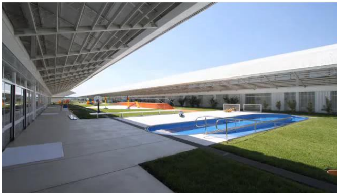
Figura 23. Diferentes blocos que se conectam através de uma circulação aberta. Fonte: www.mcb.sp.gov.br
