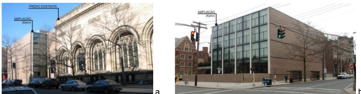
Figura 2: Ampliação da Galeria de Arte da Universidade de Yale. a) Vista do acesso e relação com o prédio existente. Fonte: < http://commons.wikimedia.org >. b) Esquina do prédio. Fonte: < www.nytimes.com >. Foto de Benjamin Genochio. Acessos em 05 set. 2011.
