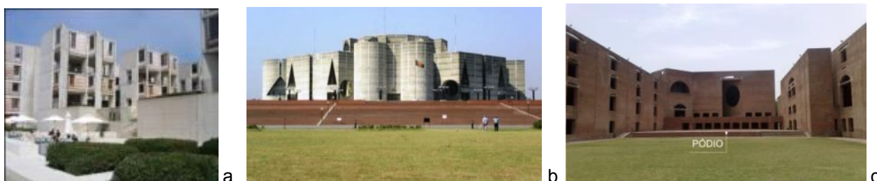
Figura 11: Elevação dos planos de base. a) Instituto Salk. Diferença de nível entre o pátio e área de convivência. Fonte: < http://emplus.com >. b) Prédio da Assembléia de Dacca sobre plataforma elevada. Fonte: < http://commons.wikimedia.org >. Autor: Karl Ernst Roehl. c) Pódio do Instituto Indiano de Administração. Fonte: < http://mineralforest.blogspot.com >. Acessos em 06 set. 2011.
