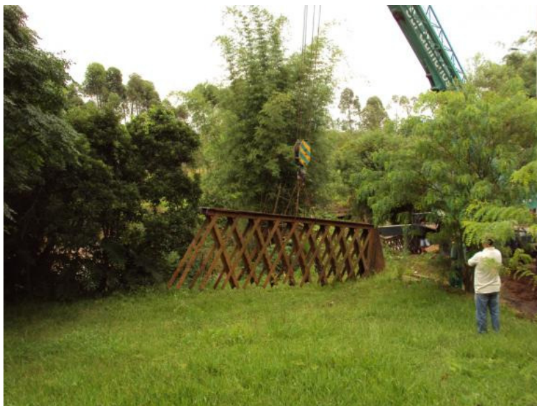
Figura 3: Retirada da Ponte São Roque. Fonte: www.criciuma.sc.gov.br
