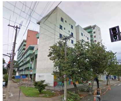
Figura 2: Vista externa do Residencial Olarias. Fonte: Autores, 2009.
