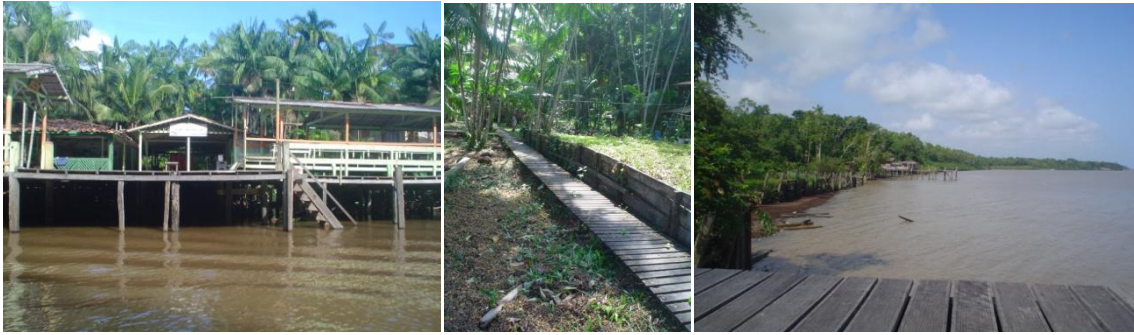
Figura 02: Circulações externas às construções em palafitas.
