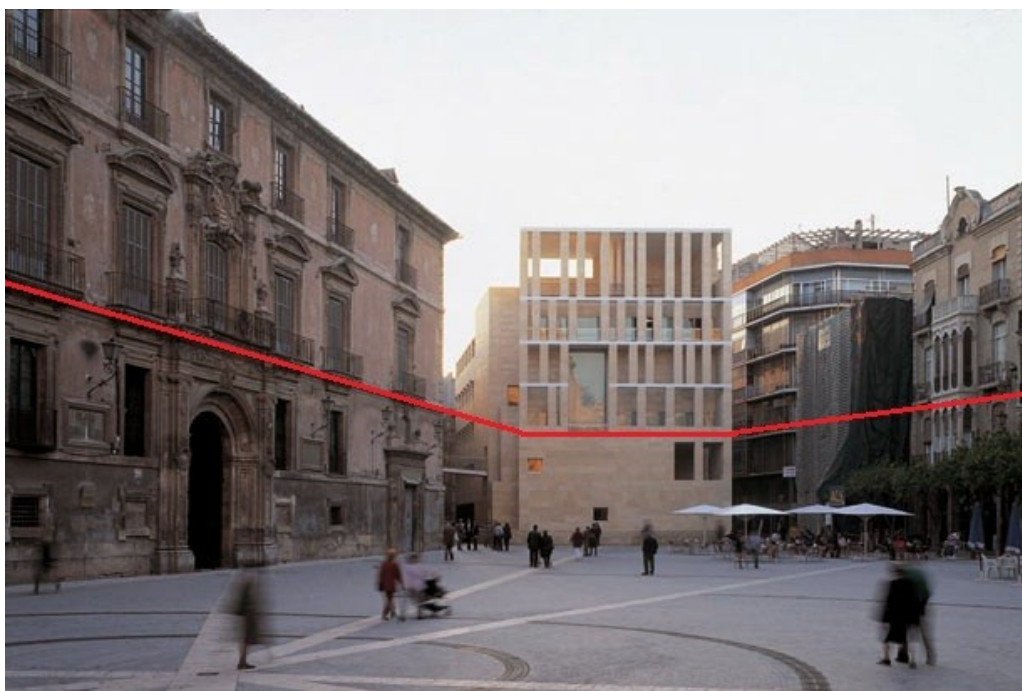
Figura 21 – Imagem da elevação principal da Sede da Prefeitura do ponto de vista do observador localizado no interior da praça. Assinala-se uma possível orientação de proporções entre o novo edifício e a arquitetura preexistente. Indicação elaborada por Camila Martins.
