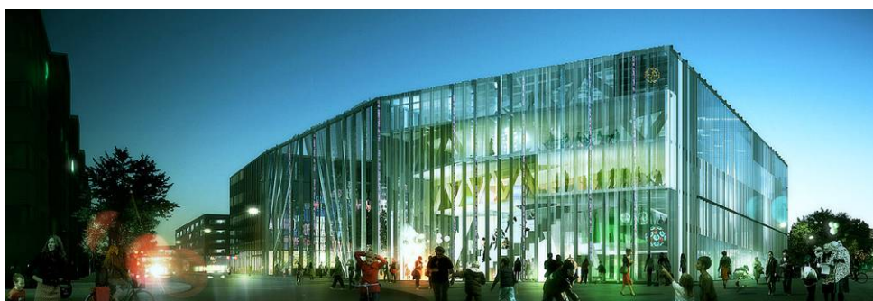
Fig. 16 – MIS, elemento de acesso e interior Fonte: Projeto Design, nº 372, p. 92 e 93
