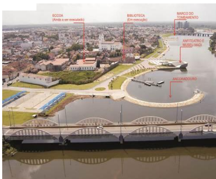
Figura 6 – Vista geral da obra de urbanização da margem esquerda do rio Acaraú. Fonte: Prefeitura Municipal de Sobral.
