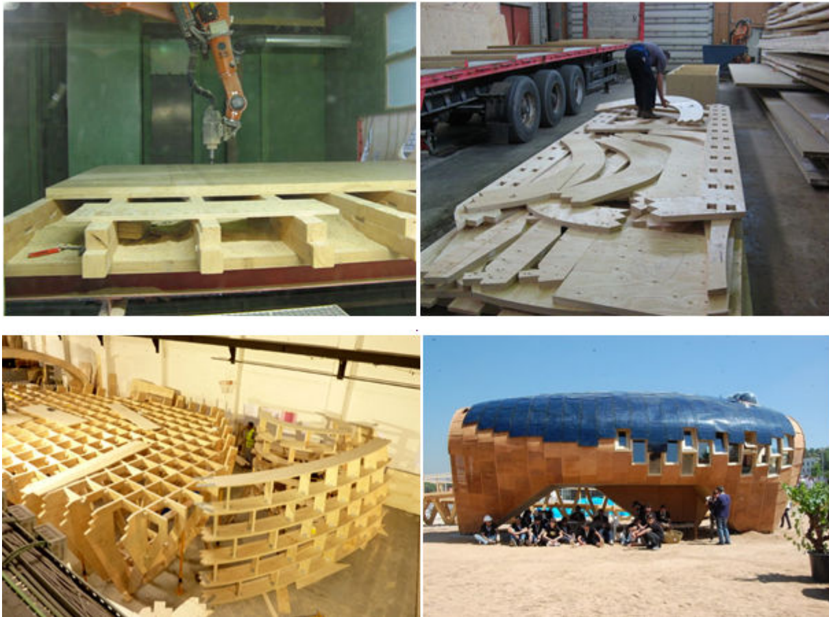
Figura 04: A) Corte dos painéis de LVL B) peças sendo embaladas para o transporte C) Montagem da base, início da construção da casa D) “Fablab House” montada em 1:1 Fonte: site do FABLAB
