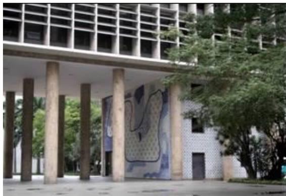
**Figura 02:** A edificação suspensa sobre pilotis.
