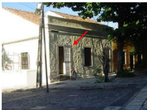
**Imagem 3: Imóvel com a substituição do reboco tradicional, levando à perda da autenticidade (2007). Fonte: autoras.**
