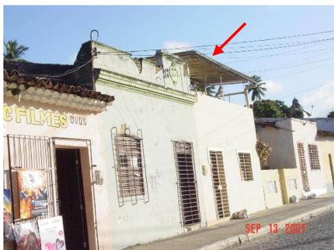
**Imagem 2: Modificação de fachada, de volumetria e de material construtivo, com a introdução de telha alumínio**
