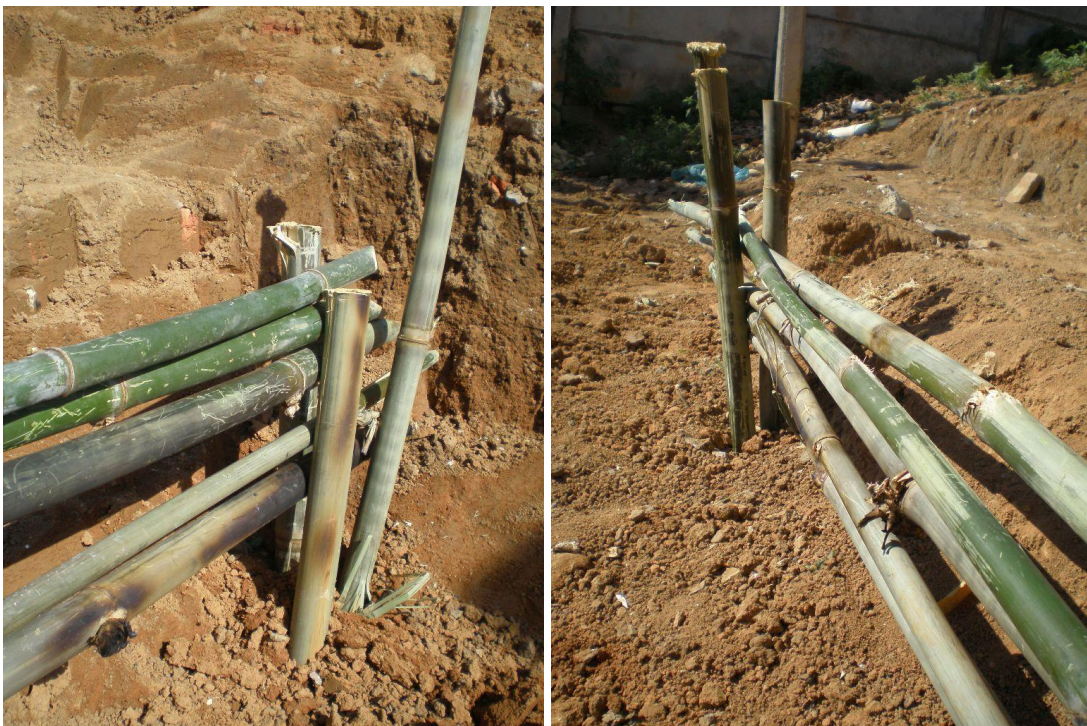
Figuras 07 e 08: detalhes da aplicação do bambu Fonte: Arquivo RUA, novembro de 2009
