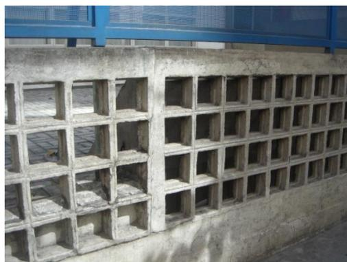
Fig. 25: Destaque para a mureta em elemento vazado.
