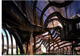
Figura 13 – Estruturas de aço do Experience Music Project em Seattle, Frank Gehry Fonte: KOLAVERIC, 2003.
