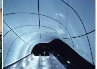
Figura 11 – Estação Funicular em estação de esqui na Austria vista interna, Zaha Hadid, 2007. Fonte: http://www.designomah.com/the-nordkettenbahnen-funicular-by-zaha-hadid-architects/
