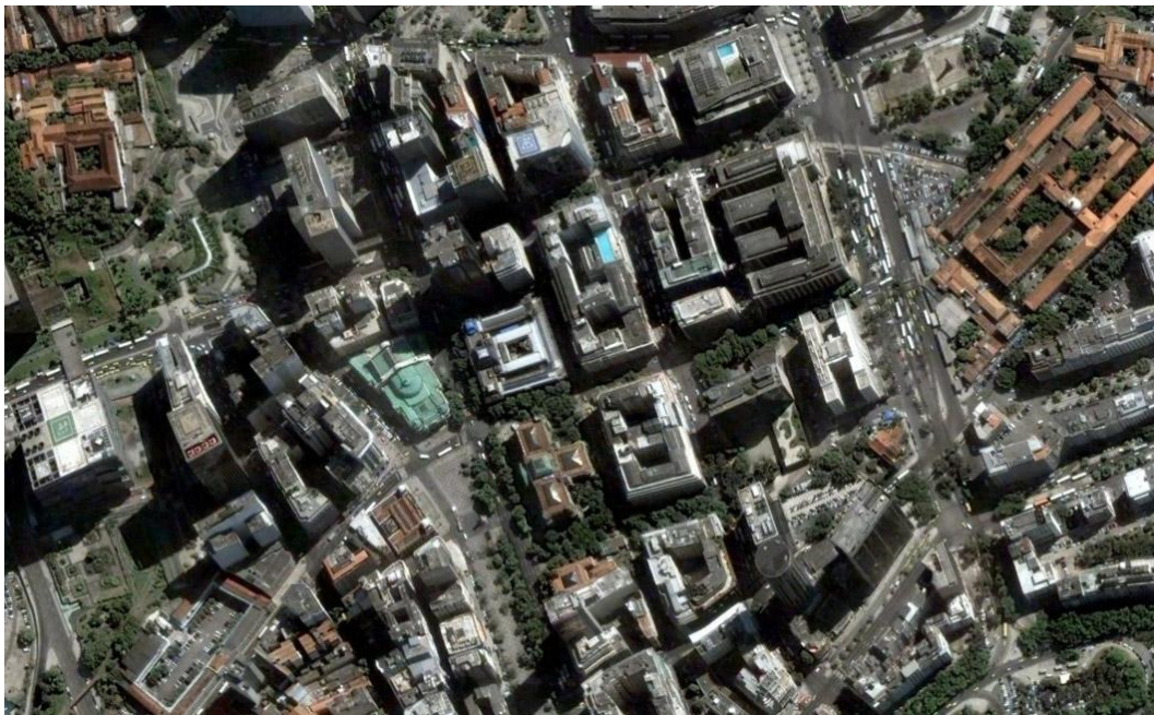
Figura 05: Lúcio Costa e equipe, Ministério da Educação e Saúde, Rio de Janeiro, 1936. O partido adotado só faz sentido por estar circundado por bairros tradicionais totalmente ocupados. O vazio resultante ganha importância por contraste. Fonte: Google Earth.
