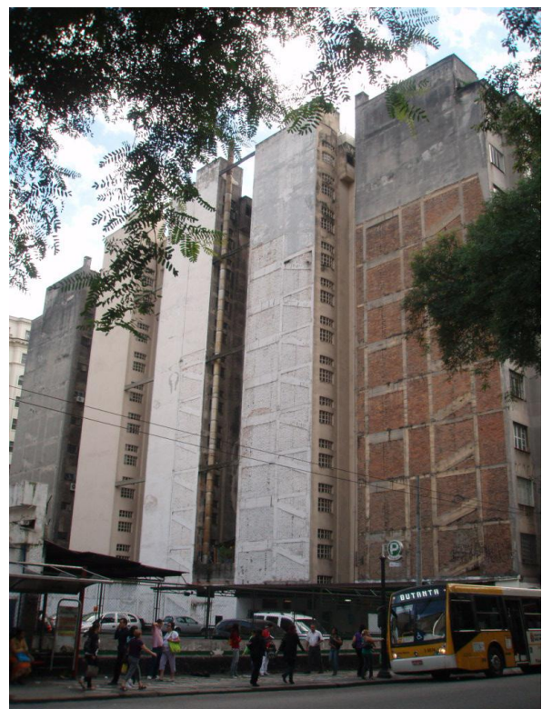
Figura 02 – Vista das empenas cegas. Fonte: acervo Luiz Alberto Backheuser.
