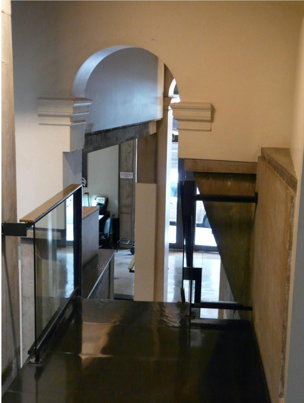
**Figura 13: Arco Original apoiado na nova estrutura de concreto**
