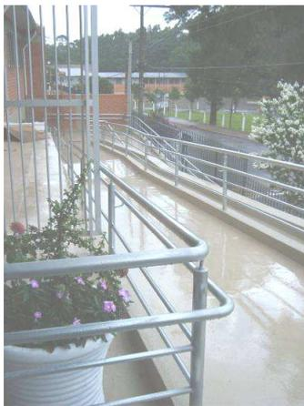
**Figura 1: Rampa de acesso à escola, contando com piso firme e antiderrapante e corrimãos em duas alturas. Fonte: Andrade, 2010**
