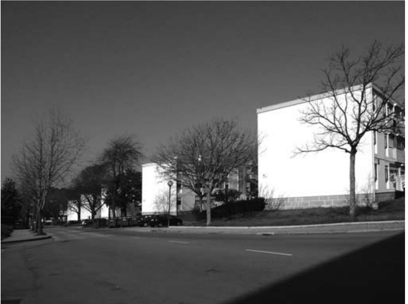
30_TÁVORA, Fernando, Bairro do Ramalde, Porto, 1952-60, f: IL, 2008
