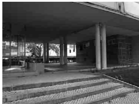
48_ [1.1] Bairro Estacas, Lisboa f: IL, 2009
