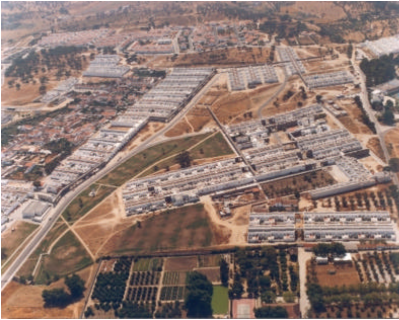
Figura 06: Conjunto Malagueira - Arq. Alvaro Siza
