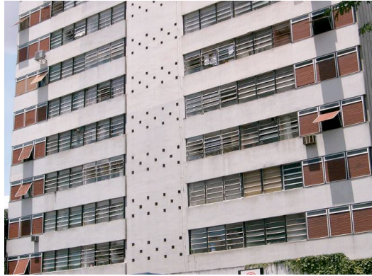
Ed. Baviera: Foto atual do edifício – detalhe fachada posterior
