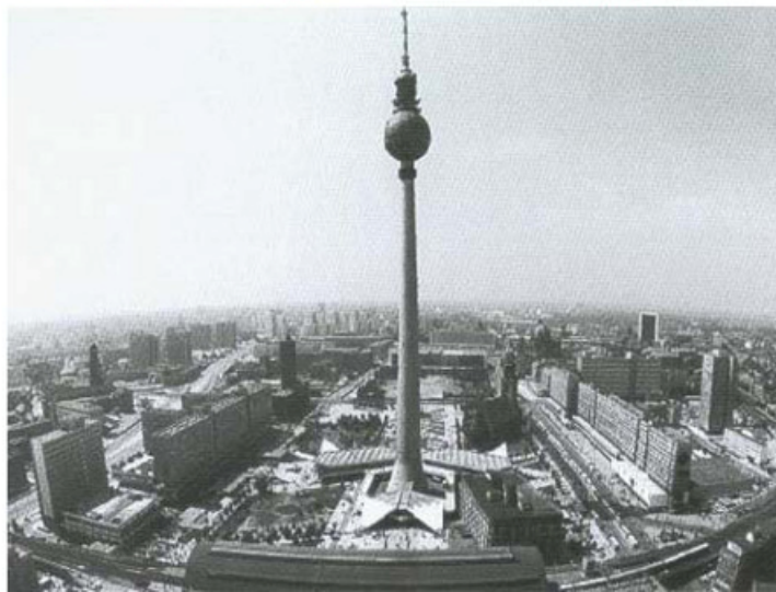
03. RFA Y RDA. Confrontación de edificios institucionales.
