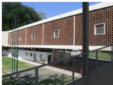
Fig.02 – Zona de transição com fechamento em cobogó, voltada para o pátio da Bandeira.
