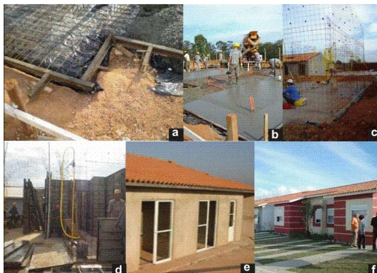
**Figura 10:** Visita ao Condomínio Terra Nova: a) Detalhe do radier; b) Concretagem do radier após colocação de tubulações; c) Detalhe da armadura e tubulações das paredes; d) Montagem dos moldes para a concretagem das paredes; e) Esquadrias externas: PVC; f) Protótipo das casas.
