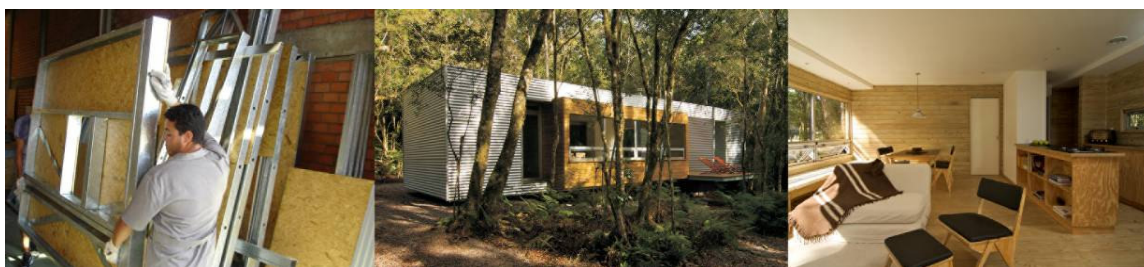
Fig.4. Fabricación de Paneles y Construcción Ejecutada (studioparalelo)
