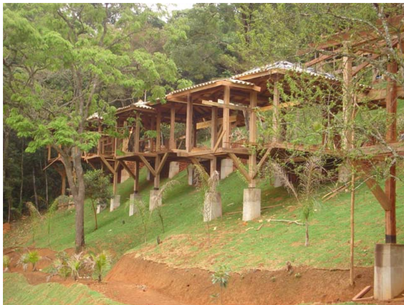
FIGURA 7- Pousada: Estrutura de madeira Fonte: Imagem cedida pelo arquiteto
