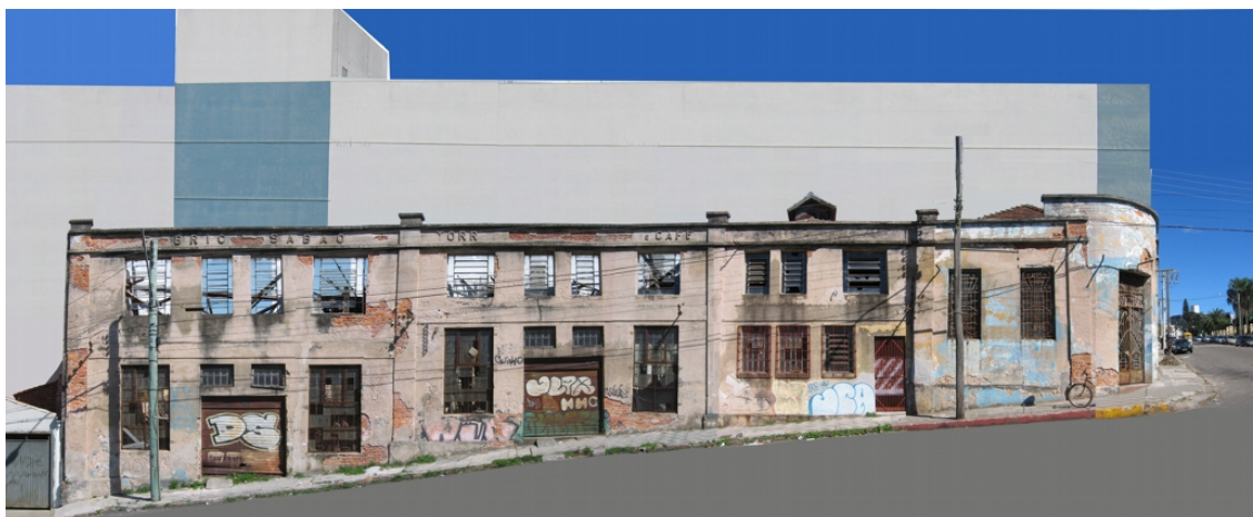
Figura 02 – Foto do conjunto de edificações que abrigou a Fábrica de Torrefação de Café, Açougue, Fábrica de Gelo e Sabão. FONTE: acervo dos autores, 2006.
