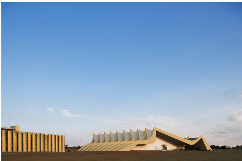
Ilustração 09: Neste projeto os pilares laterais e a cobertura tensionada formam um único desenho, utilizando-se o mesmo material em sua concepção.
