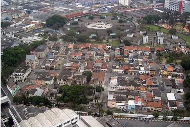
Figura 3 - Vista aérea da vila com os prédios históricos à esquerda
