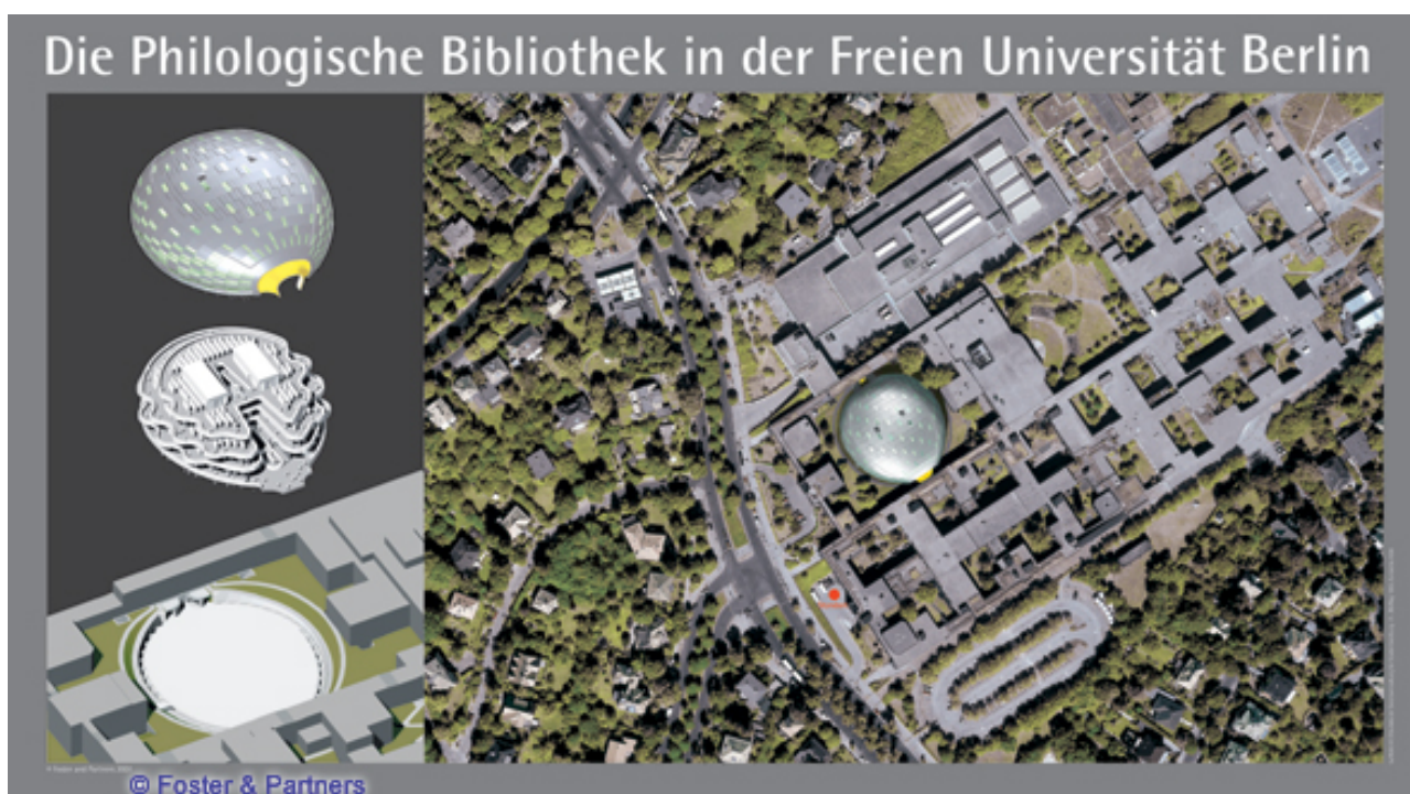
Figura 04: imagem aérea mostrando a implantação da FUB e da nova biblioteca na área em Dahlem (Fonte: http://www.fosterandpartners.com/Projects/0980/Default.aspx )
